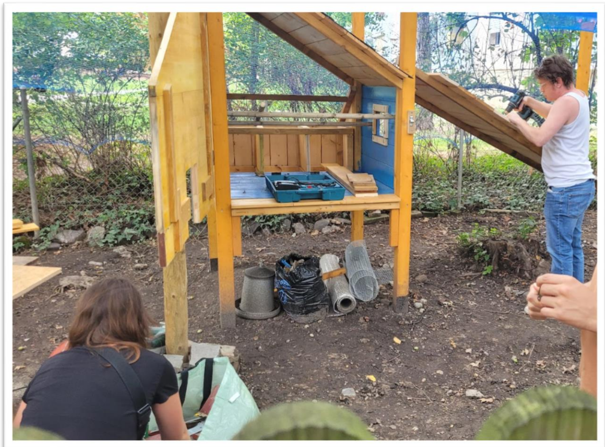
Le poulailler en construction
